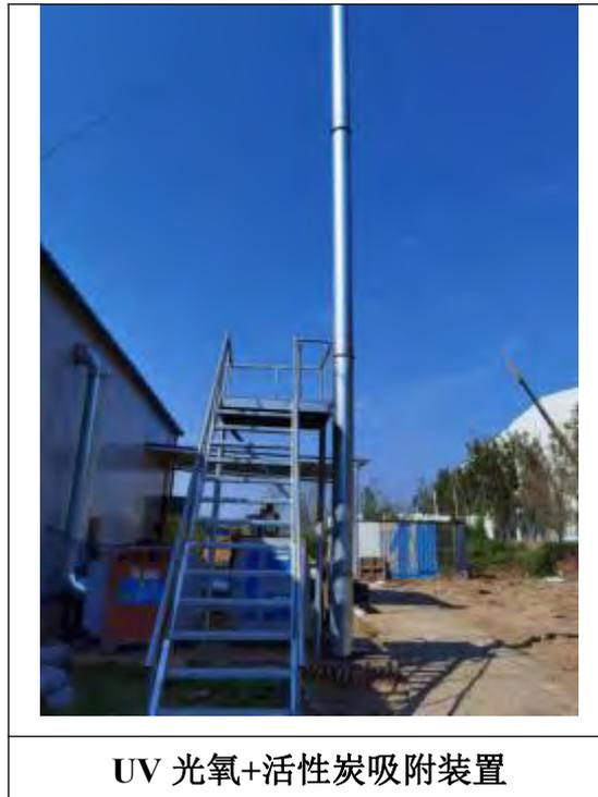
图 4.1-3 生产车间工艺废气治理设施图
